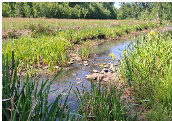
een keiendam in de Ruimsloot houdt het water op het juiste peil, en waarborgt de afstroom bij pieken
