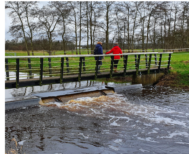
via een brug kunnen wandelaars naar de overkant van het Deurzerdiep
