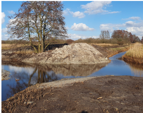
er worden enkele bulten aangelegd met dieper water daarnaast, speciaal voor de bever
