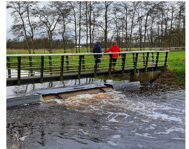
de brug over het Amerdiep wordt gebruikt door wandelaars en mtb-ers
