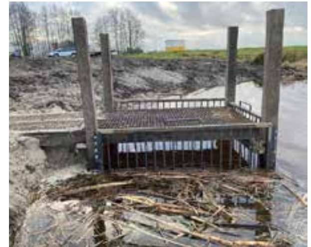
een 'bevermisleider' voorkomt dat bevers de uitstroomduiker gaat dichtstoppen
