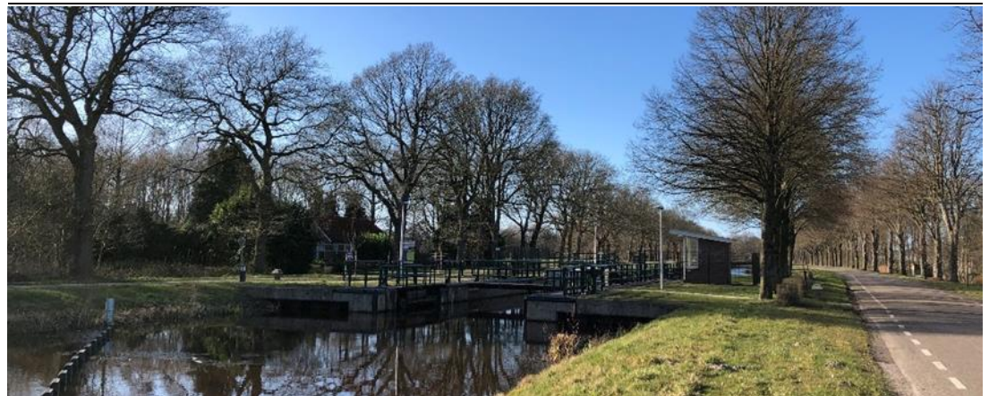
Figuur 34: Schutsluis 3 in het Oranjekanaal.
