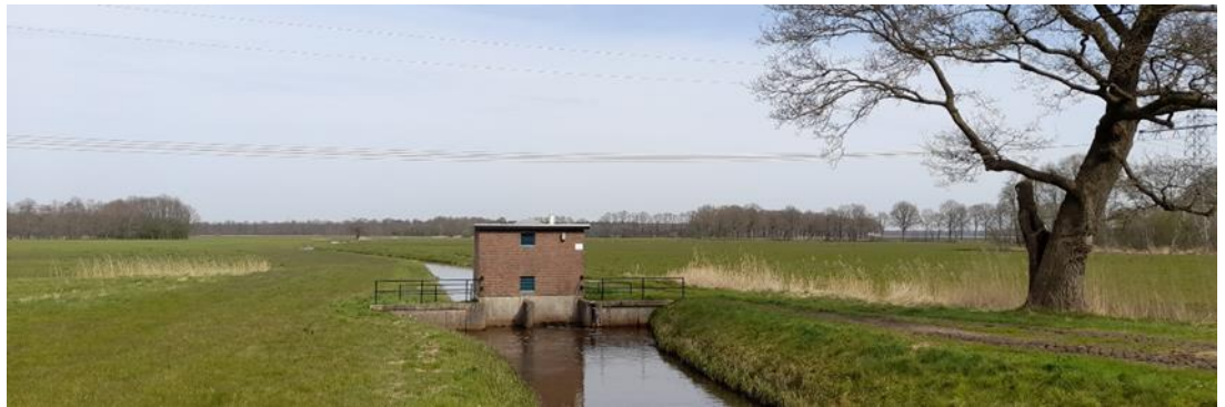
Figuur 35: Gemaal Elperstroom ter hoogte van het Oranjekanaal.
