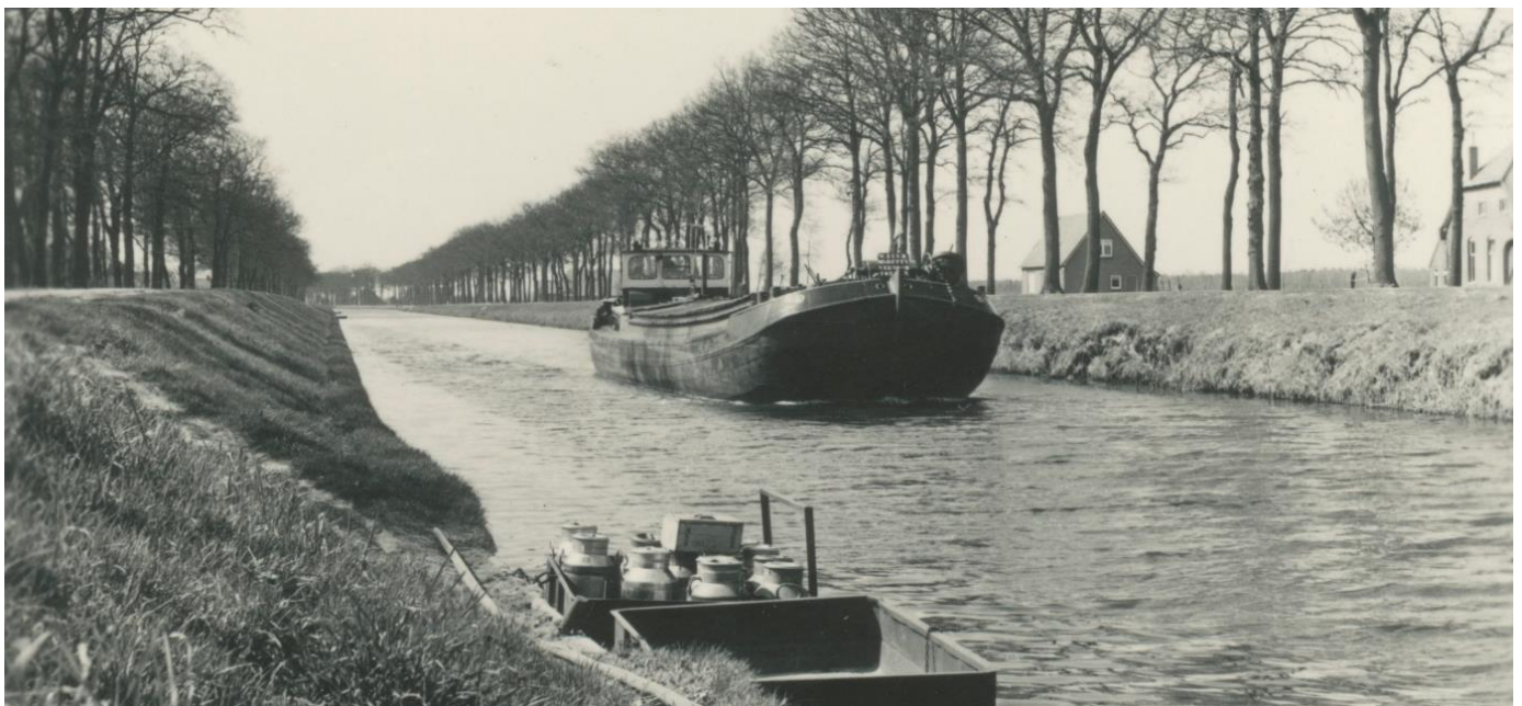
Figuur 15: Oranjekanaal ter hoogte van Orvelte, 1968.
