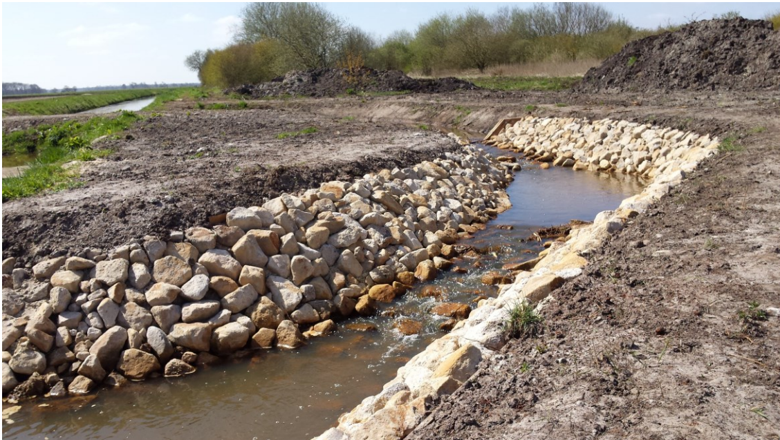
Foto 2: De gerealiseerde vistrap met stuw in de ecologische verbindingszone Ruimsloot
