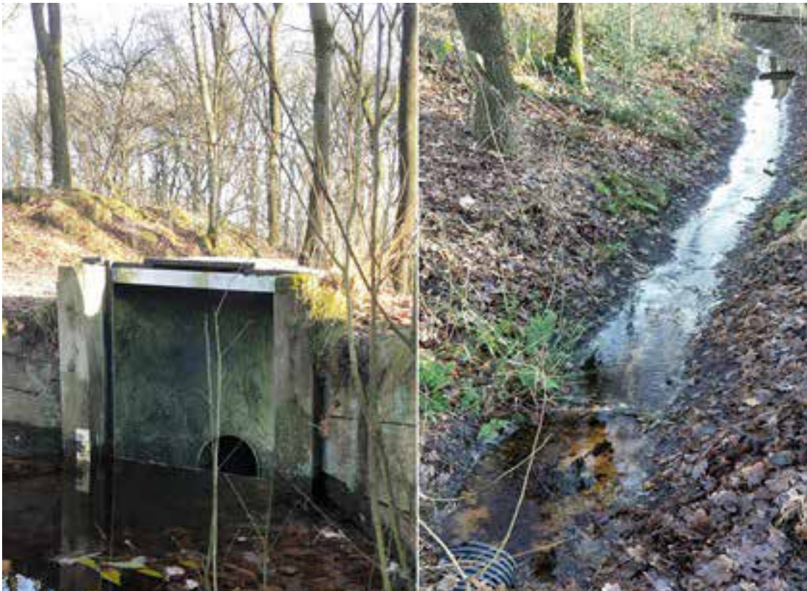
Figuur 27: Stuw met achterliggende gegraven afwatering
